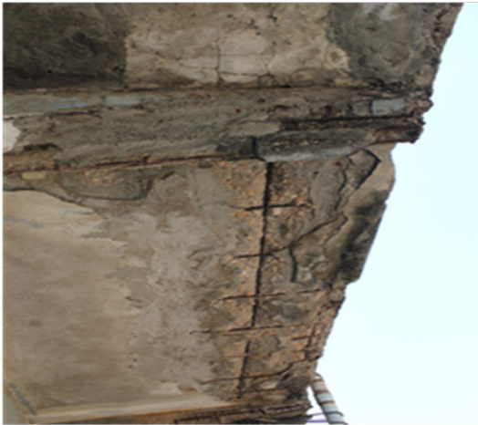
b) Destacamento do betão, exposição e corrosão do aço das varandas
