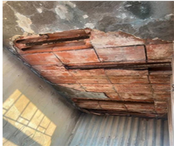
b) Destacamento do betão, exposição e corrosão do aço das varandas
