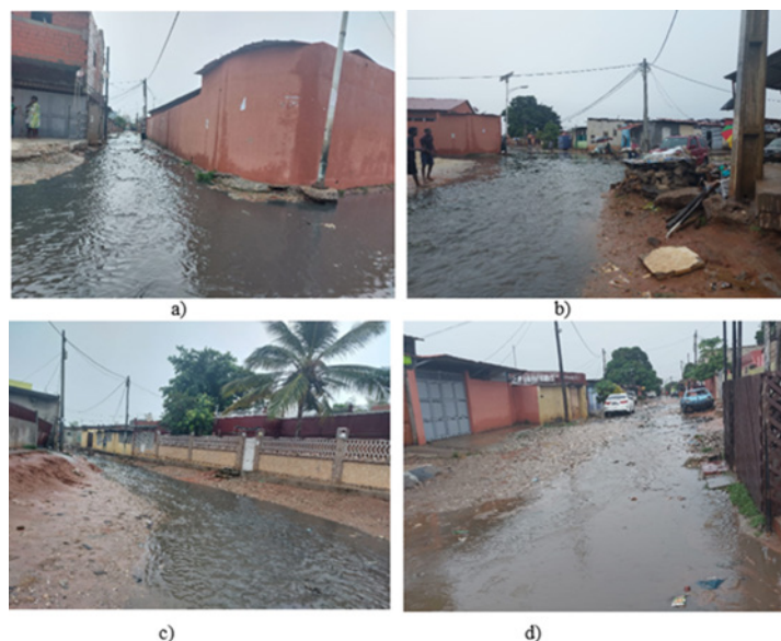
Figura 2– Estado das ruas em épocas chuvosas, a) Travessa da rua 9 - jusante, b) Rua 11 - jusante, c) Rua 40 - montante d) Rua 7 – jusante.
